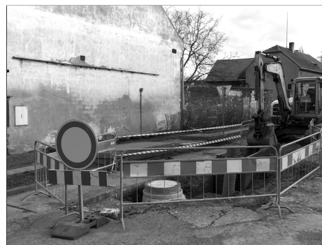
Výkopové práce pokračují pozvolna. . .
